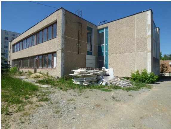
Budova sociálnych služieb pred rekonštrukciou
