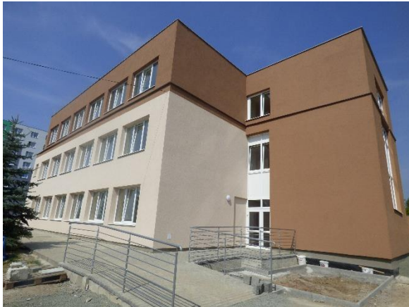
Budova sociálnych služieb pred ukončením rekonštrukcie
